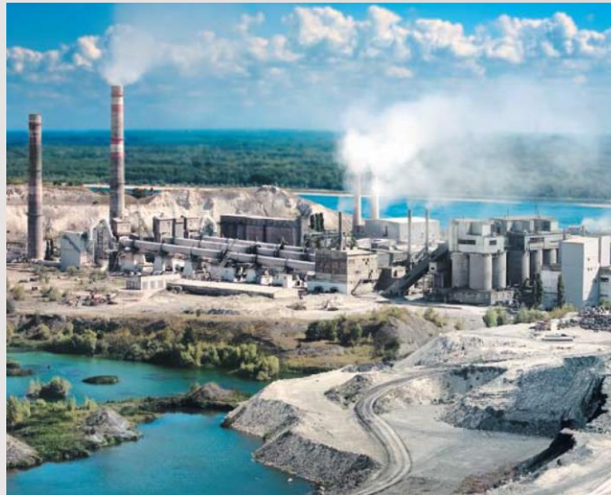
Цементный завод в Вольске
