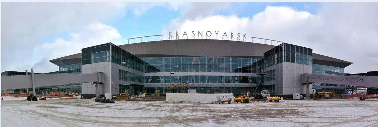
Строительство нового пассажирского терминала аэропорта «Емельяново»
