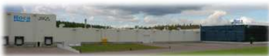
Тосно (Ленинградская область): керамические изделия
