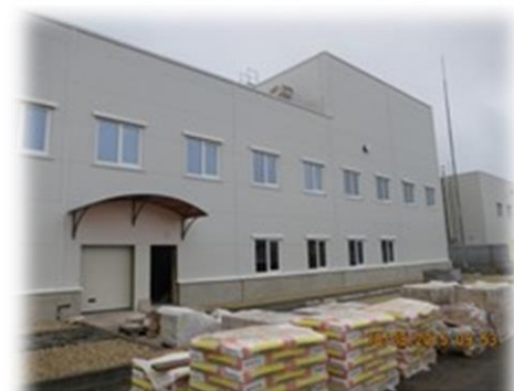
Складирование материалов (Клей для плитки, плитка керамогранит). Storage of materials.
