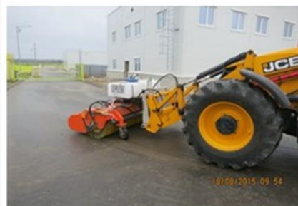
Уборка территории (ось Г/7). Daily Site cleaning (axis G/7).
