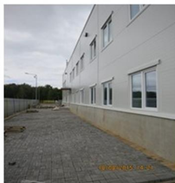
Вид объекта.(ось 1-7). Site overview (axis 1-7).
