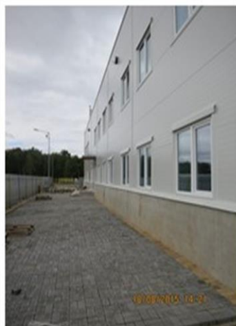
Вид объекта.(ось 1-7). Site overview (axis 1-7).
