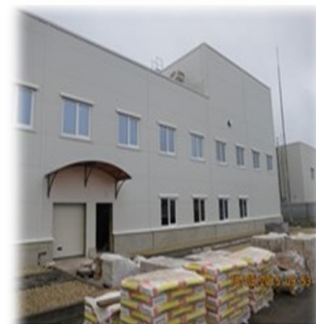
Складирование материалов (Клей для плитки, плитка керамогранит). Storage of materials.
