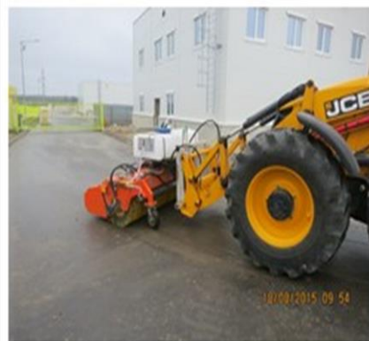
Уборка территории (ось Г/7). Daily Site cleaning (axis G/7).
